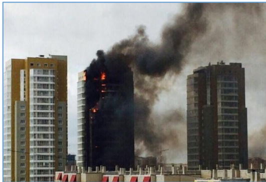
Красноярск: горит теплоизоляция фасада жилого дома, построенного для сотрудников МЧС.
