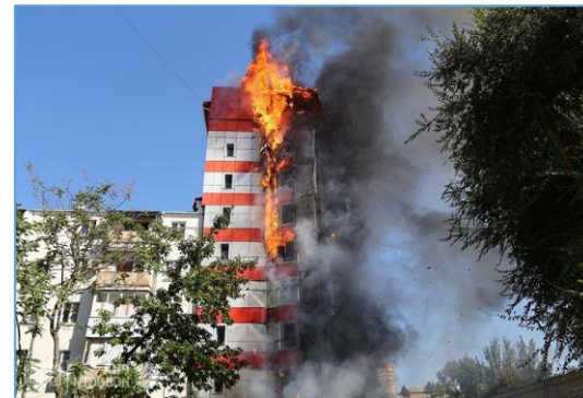
Ростов-на-Дону: горит фасад многоэтажного отеля. Тепловая изоляция - «негорючая» минвата.
