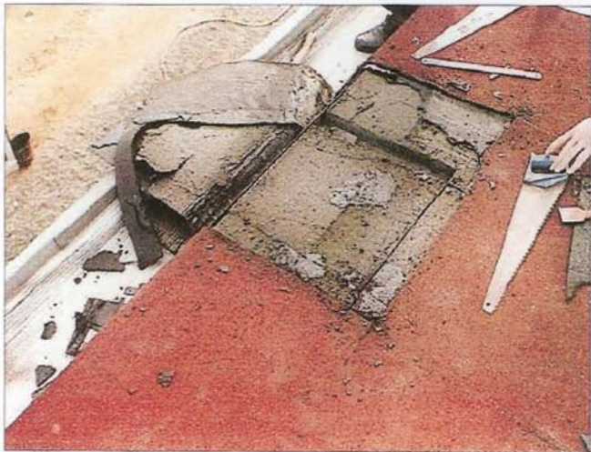
Удаление мембраны со слоя FOAMGLAS®
