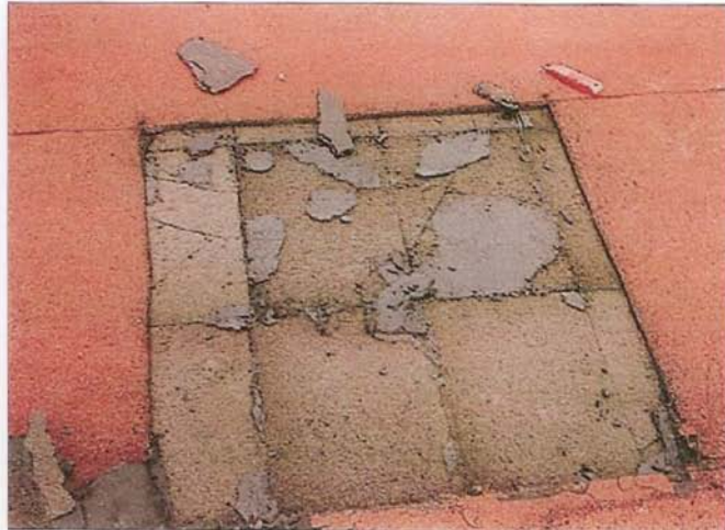
Демонтаж изоляции и мембраны над водосточной трубой: все слои абсолютно сухие.
